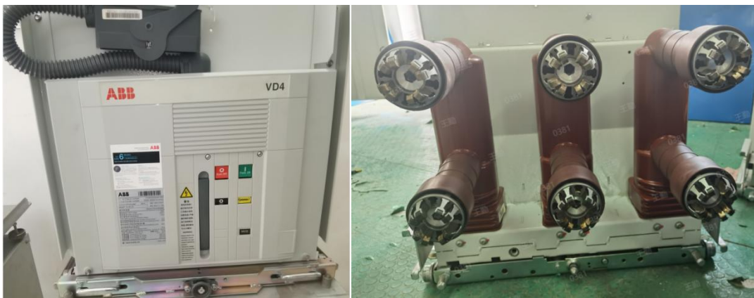
图5 10kV 真空断路器
