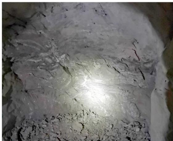
图 3 楔形掏槽爆破效果
