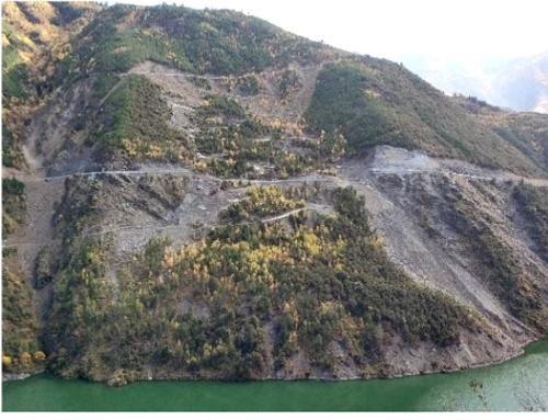
图6 堆积体圆弧型滑塌变形
