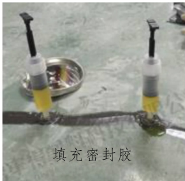
图 4 试验段渠道混凝土贯穿性裂缝处理过程照片
