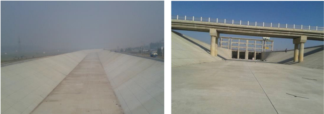
图 5 南水北调渠道混凝土衬砌成型质量效果图
