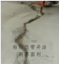
图 4 试验段渠道混凝土贯穿性裂缝处理过程照片
