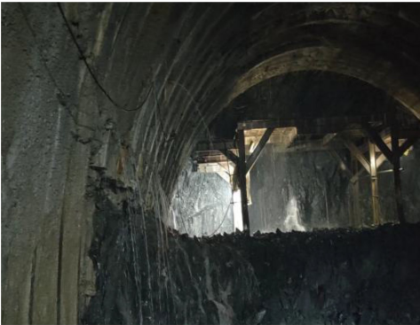
图 7 突涌水照片
