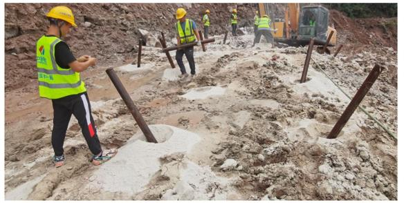
图2 二氧化碳致裂管填塞照片
