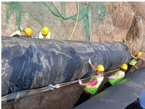
图 2 倒链安装示意图一
