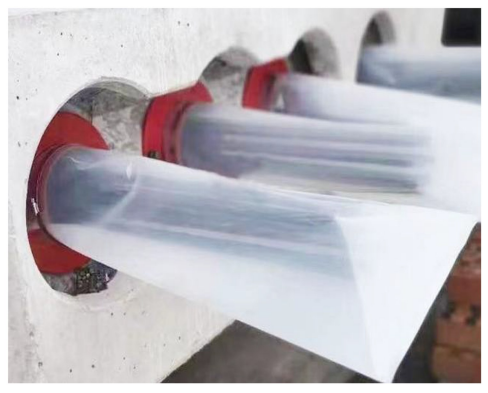
图 3 钢绞线保护套示意图
