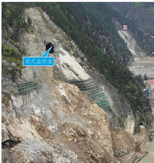
图 3 洞式溢洪道洞脸边坡形象面貌
