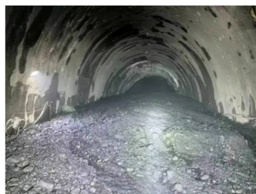
图 1 采用硬质石渣反压回填照片
