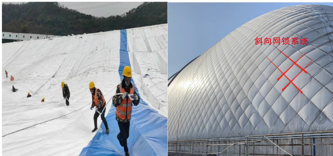
图4 斜向钢索系统示意图
