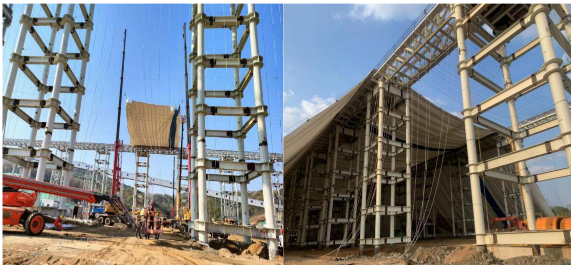
图 3 展膜铺设施工图
