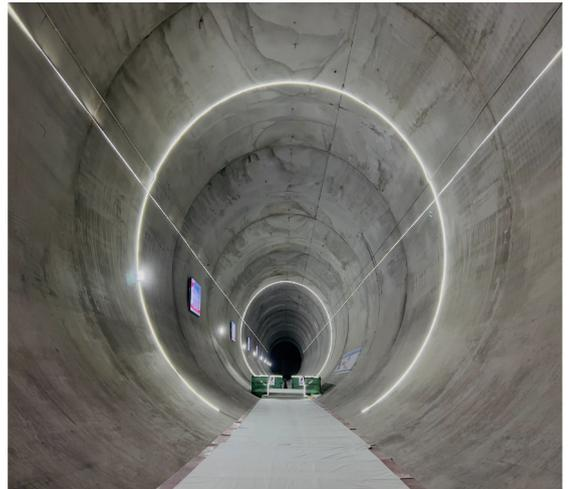
图3 大洞径全圆针梁台车底拱混凝土衬砌效果
