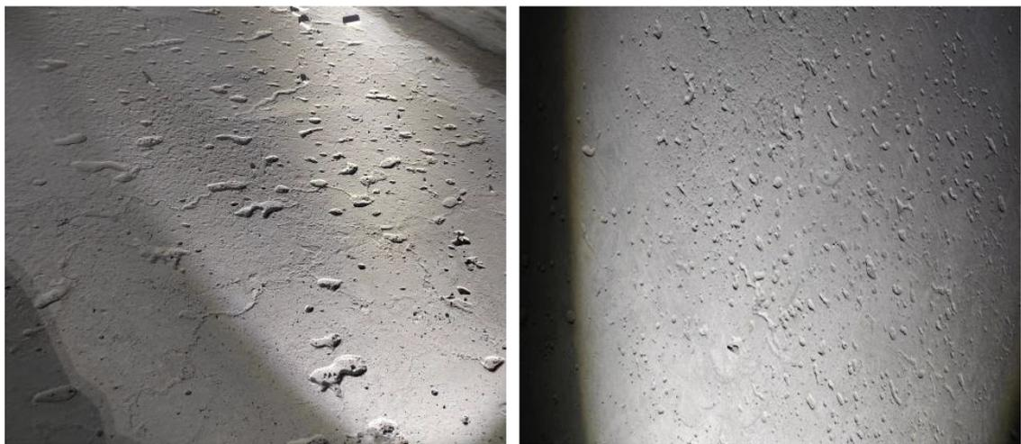
图 2 底拱混凝土表面气泡水纹状况
