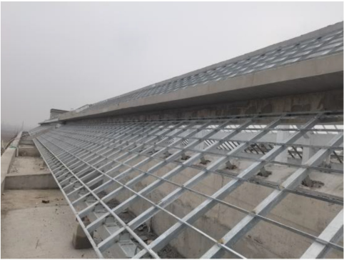
图 4 挂瓦条布置图
