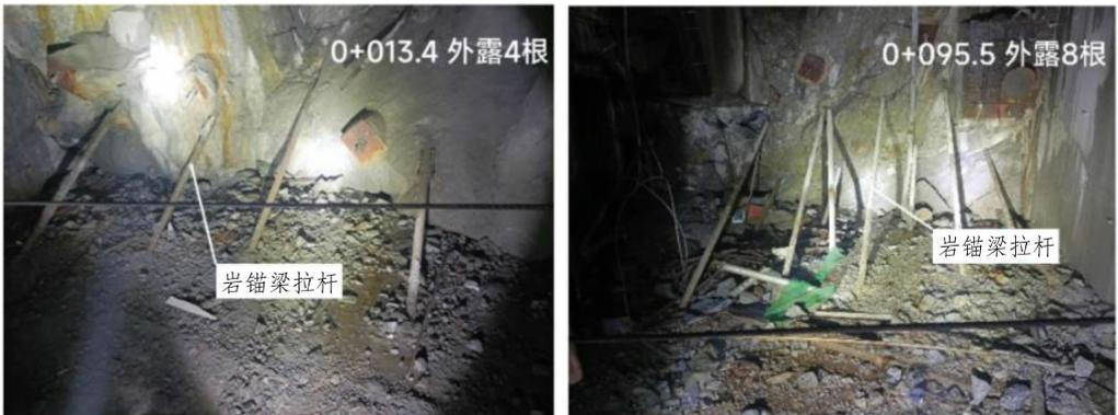
图1 岩壁吊车梁拉杆直接外露
