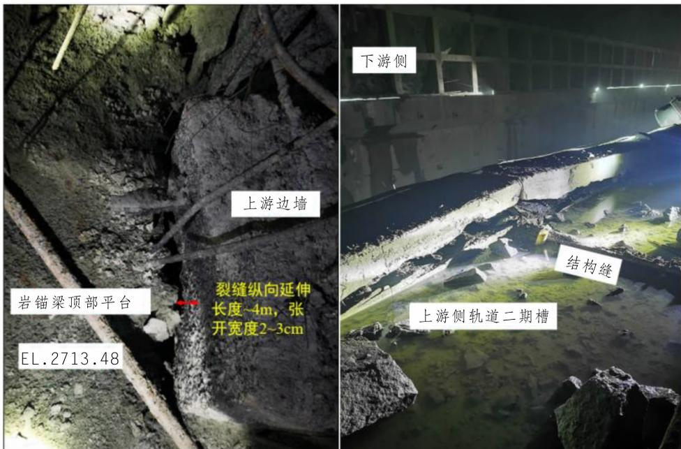
(a)岩壁吊车梁与岩壁脱开
