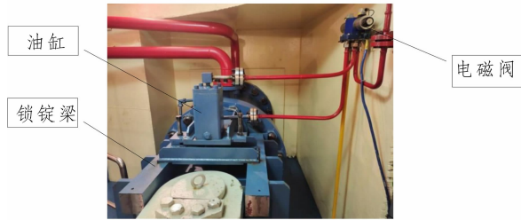
图1 接力器锁锭装置实物图
