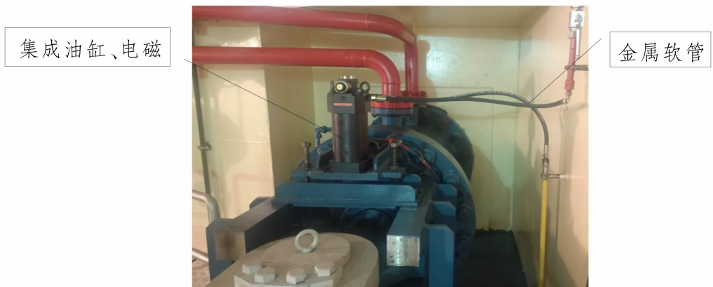
图 3 接力器锁锭装置改造后效果图
