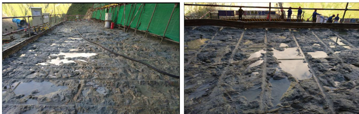
图 4 二道坝底板工艺试验开挖效果图
