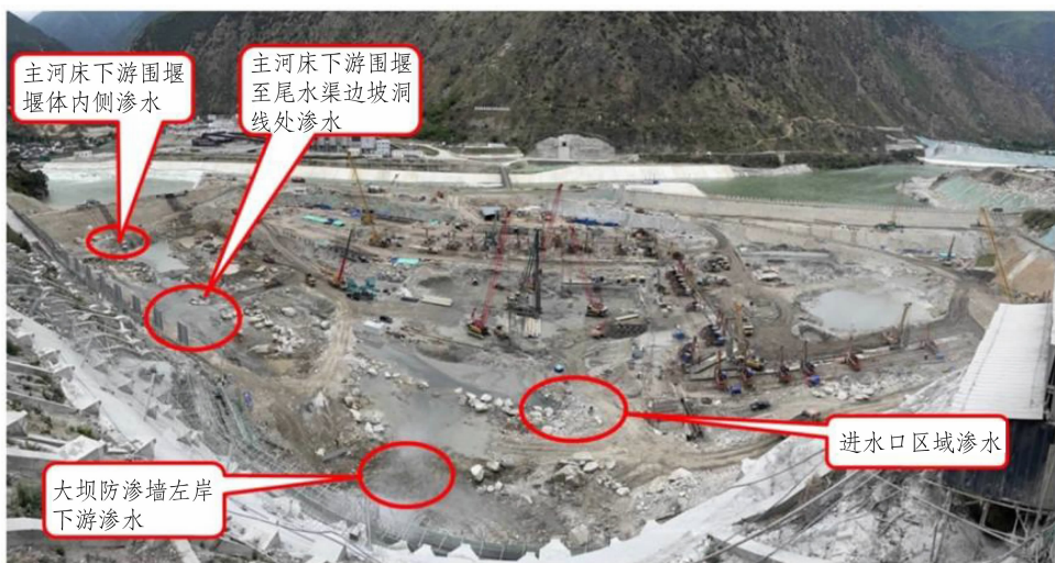
图 1 二期基坑渗水位置示意图
