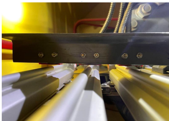
图4 清理后的导叶位移传感器
