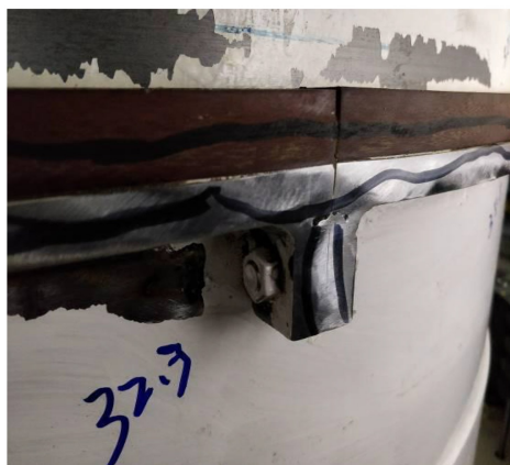
图 5 上导油槽内档油筒挡油圈、集油环打磨
