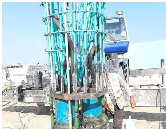
图 3 喇叭筋加工示意图
