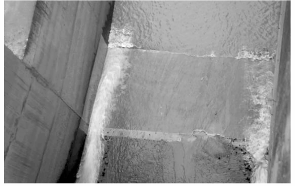
图 5 3# 闸室底板汛后检查情况
