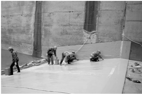
图 4 表面涂刷 SK 手刮聚脲照片
