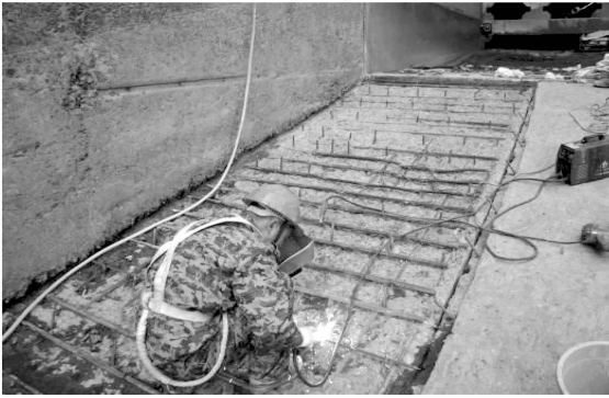
图 3 凿毛及补焊钢筋照片
