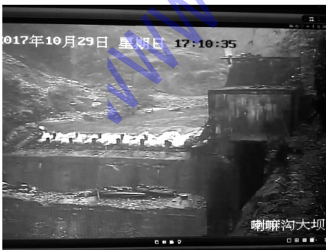
图 3 喇嘛沟电站大坝 2# 摄像机拍摄图
