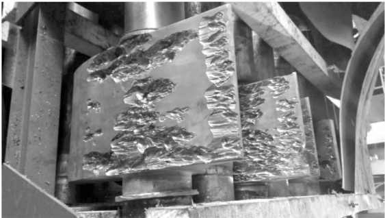
图 1 运行 5 a 的柳洪水电站 1#机组导叶照片
