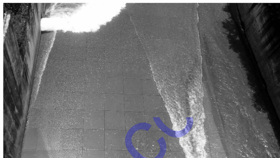
图 1 护坦衬护钢板图
