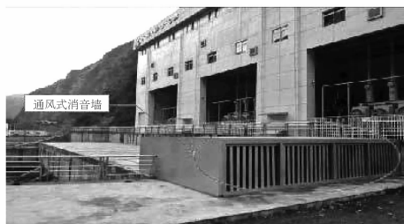
图4 通风式消声器示意图
