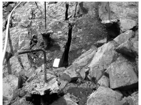
图1 右岸坝基C型趾板基岩照片
