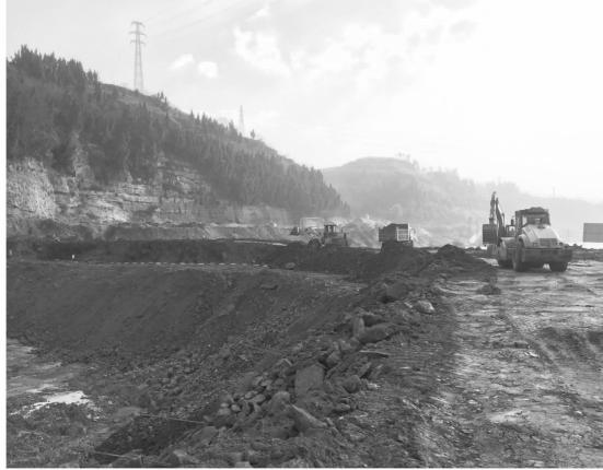
图 2 围堰填筑施工过程图
