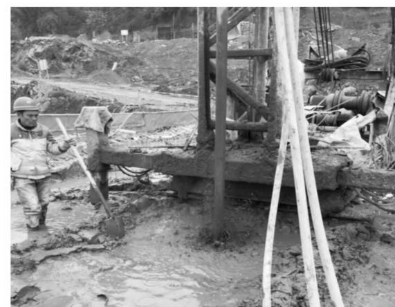
图 3 高喷灌浆施工过程图
