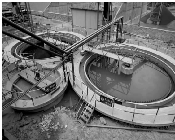
图1 砂石废水处理系统
