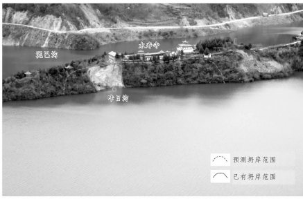
图 1 昨日沟侧坍塌变形体全景图
