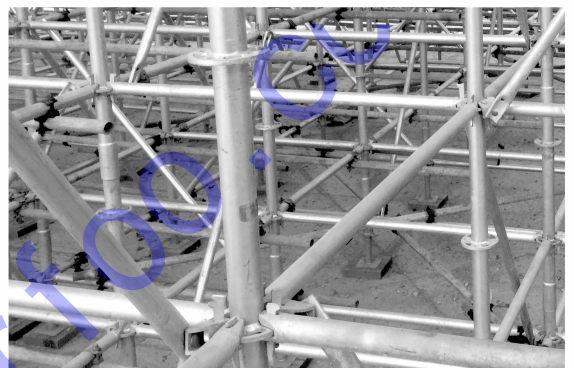
图1 盘扣式支架连接方式示意图
