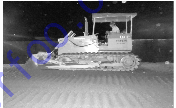
图2 碾压混凝土摊铺作业示意图
