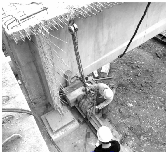
图8 横向顶推施工现场图
