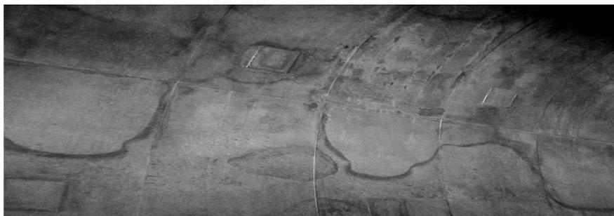
图2 混凝土层间不均匀形成的混凝土表面色差图
