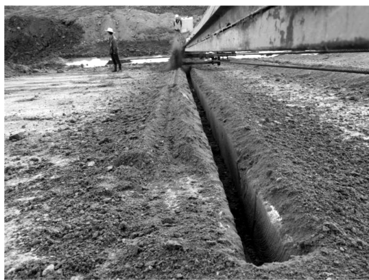
图 2 桁架式开槽机开槽施工示意图
