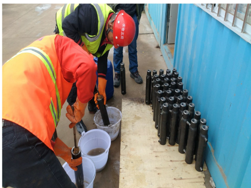
图 6 接长梁板主筋连接施工照片
