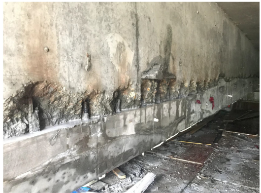
图 2 梁底加大截面施工照片
