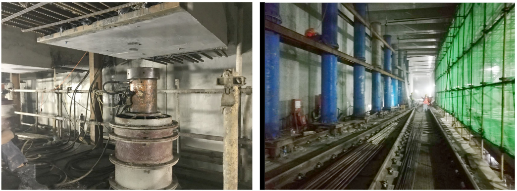
图4 PLC液压同步顶升施工照片
