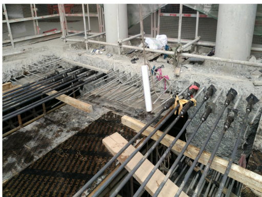
图 6 接长梁板主筋连接施工照片
