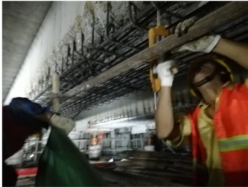
图 2 梁底加大截面施工照片
