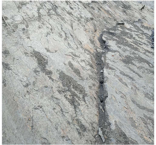
图1 浅表层顺坡向裂隙发育与岸坡区域出露情况
