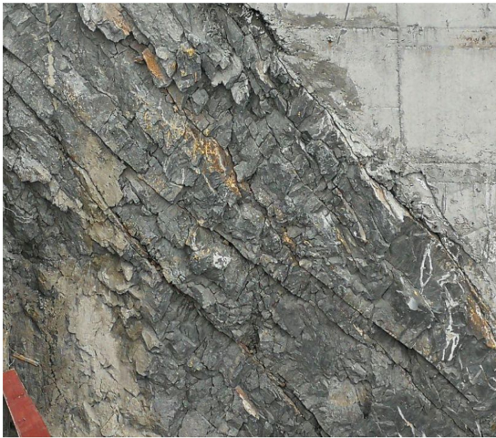
图1 浅表层顺坡向裂隙发育与岸坡区域出露情况
