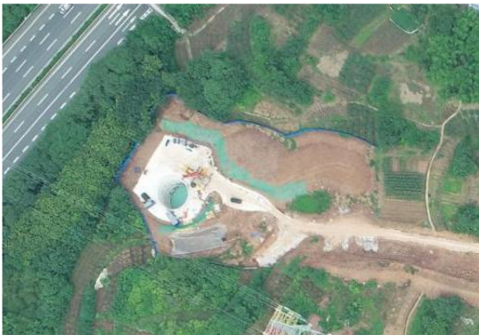
图3 穿重庆绕城公路顶管工作井航拍图
