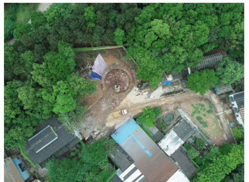
图 2 齿轮厂(中继井)顶管工作井航拍图
