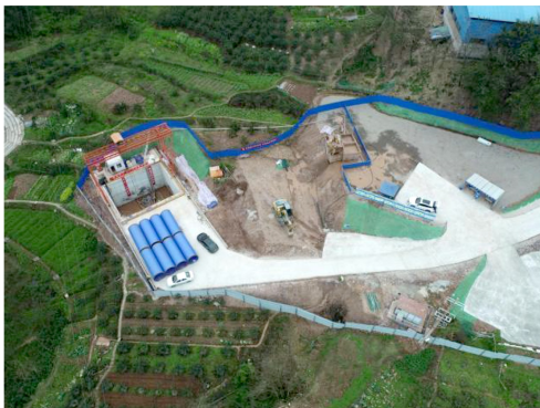
图 1 齿轮厂(小桩号)顶管工作井航拍图
