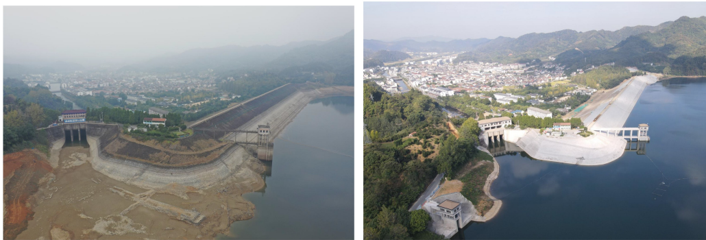
图 4 陈蔡水库大坝迎水面护坡改造前后效果对比图
