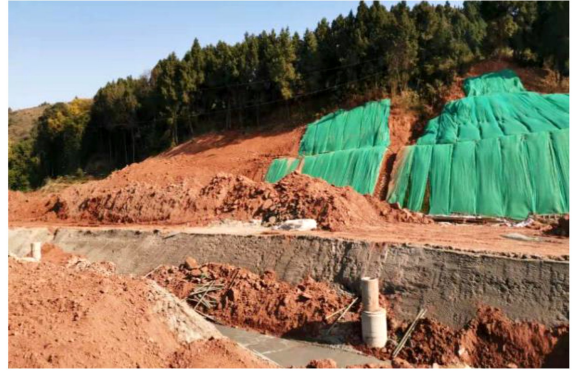
图2 开挖形成的路堑边坡
