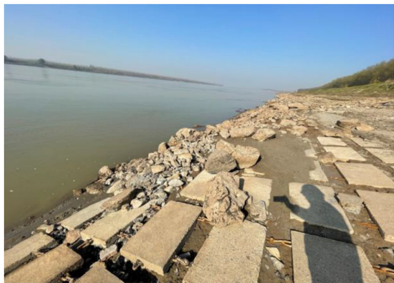
图 2 现场护坡连锁块及抛石图
