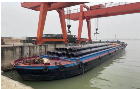
图 4 钢管桩装船示意图
