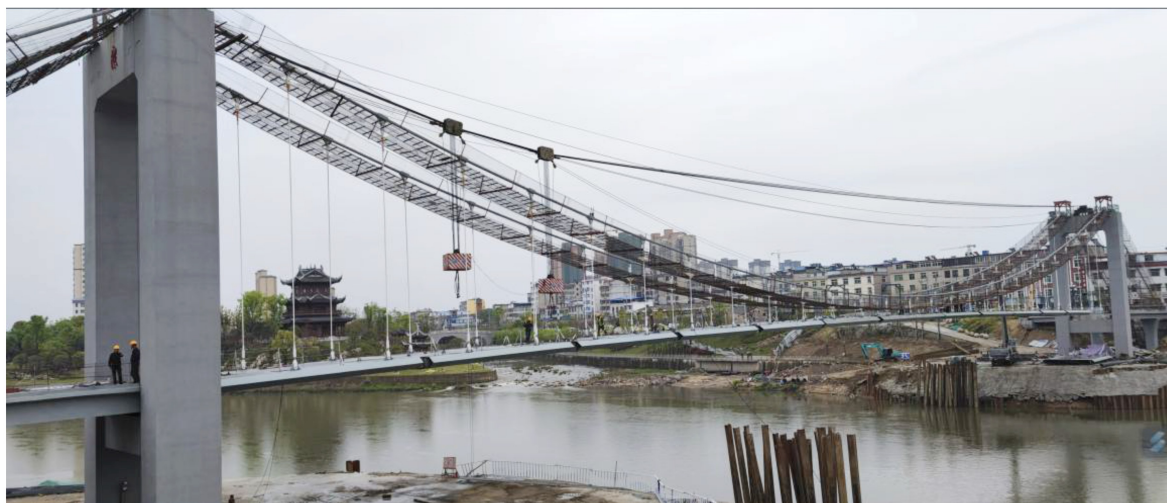
图 7 钢箱梁吊装实景图
