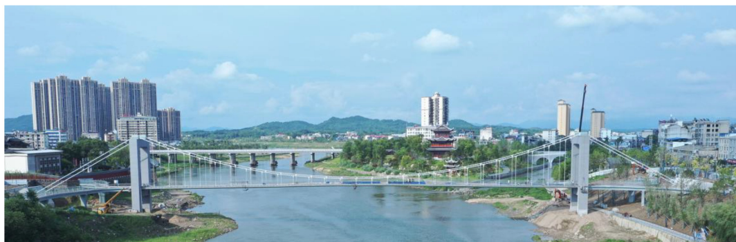
图 1 悬索桥建成后实景图
