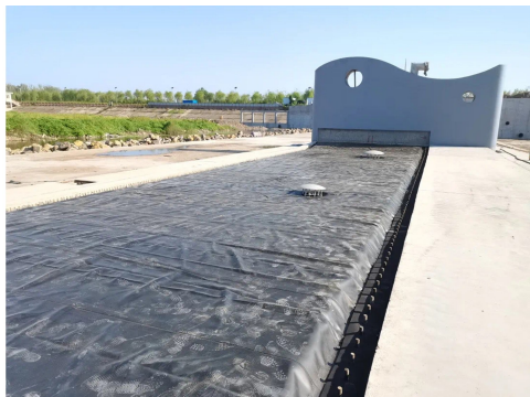
图 1 坝袋底层锚固示意图
