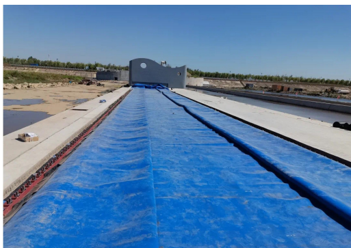
图 2 坝袋外层锚固示意图
