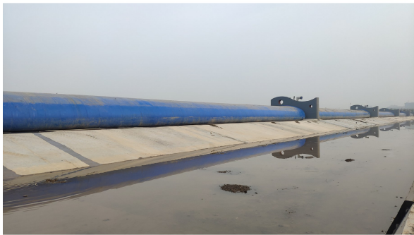
图 3 坝袋充水试验示意图
