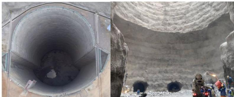
图6 调压井大断面异形轮廓结构和倒悬闸室开挖成型效果见图
