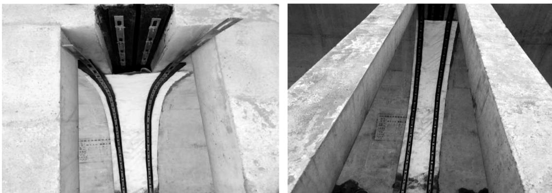
图6 U型止水闭水装置示意图
