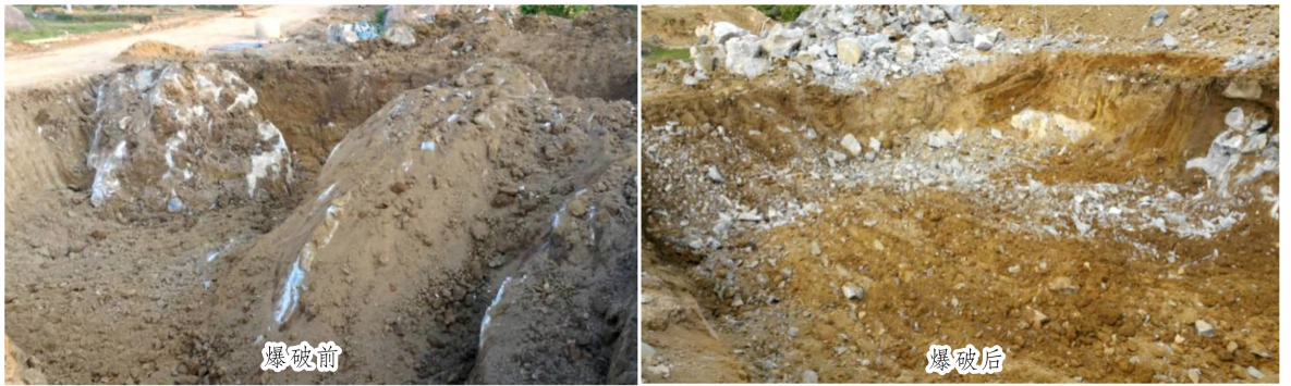
图3 浅部开挖爆破纠偏处理现场图
