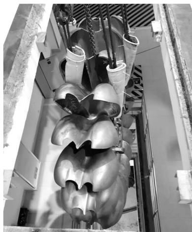
图1 水斗式转轮立式吊装图
