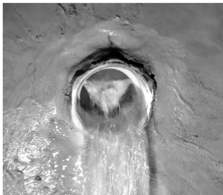
图 1 止回阀排水管示意图
