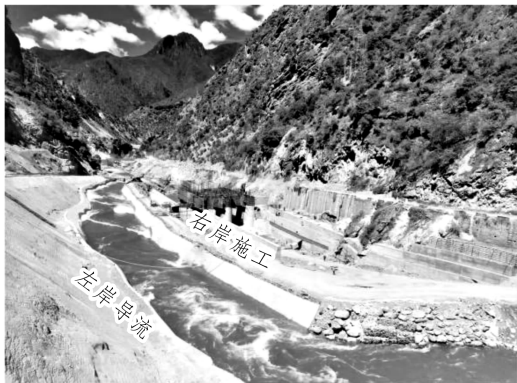
图 1 现场左岸导流、右岸施工效果图
