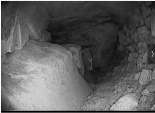
图 1 32 号孔预注浆前孔内摄像资料
