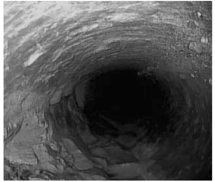
图 3 5 号孔固壁灌浆后效果图
