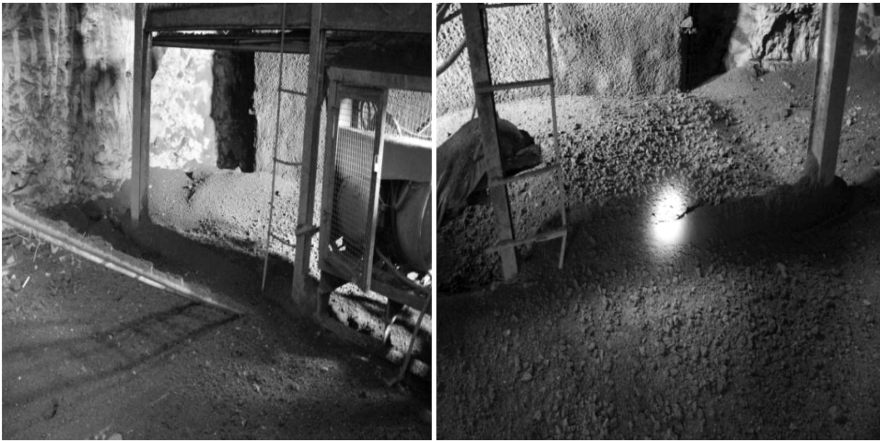
图 1 掺纳米(左)与基准混凝土(右)回弹率现场效果图
